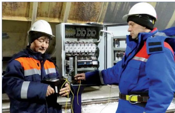
Замер сопротивления изоляции щита в здании ОРЭП. Слева направо: Ж.М. Бообеков, электромонтер по ремонту ВЛ; Р.Г. Сурнов, электромеханик
