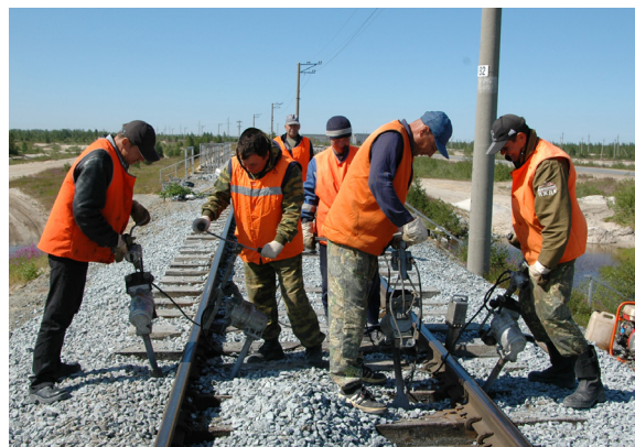
Путевые работы на участке Коротчаево – Новый Уренгой
