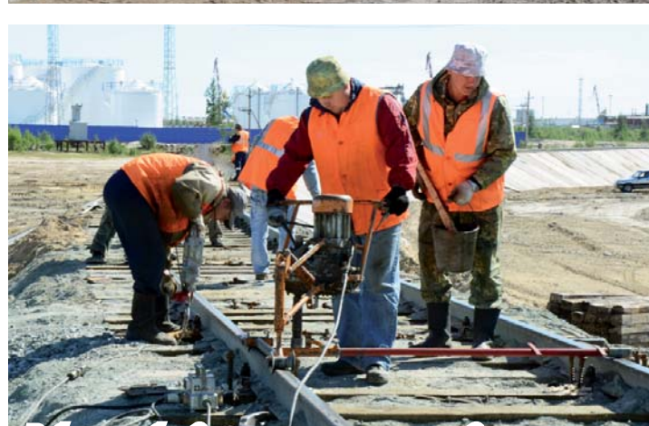
Работы по оборудованию повышенного пути для выгрузки и хранения инертных материалов, ст. Ево-Яха
