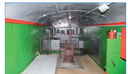
Внутренний вид СДПМ № 3112 после ремонта
