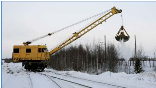
Работа железнодорожного крана Путьрем на путях локомотивного депо
