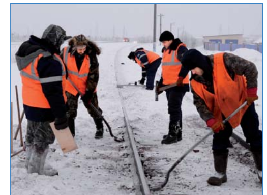
Выправка пути по уровню на 645 км, перегон Новый Уренгой – Фарафонтьевская; работы ведет дистанция пути
