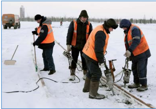
Выправка пути ООО «ЯМАЛ-ЛОГИСТИК» на ст. Коротчаево; работы ведет Путьрем
