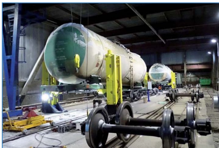
Текущий отцепочный ремонт грузовых вагонов, ОРЭП на ст. Новый Уренгой
