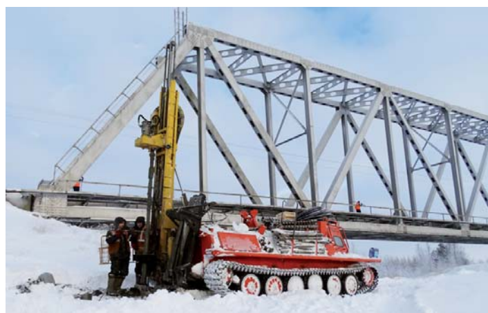
Инженерно-геологические работы на перегоне Тыдыл – Нартовая. Работы ведет ООО «ТрансПроектИндустрия», 05.02.2019
