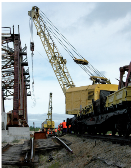
Путевые работы на перегоне Пангоды – Надым-Пристань
